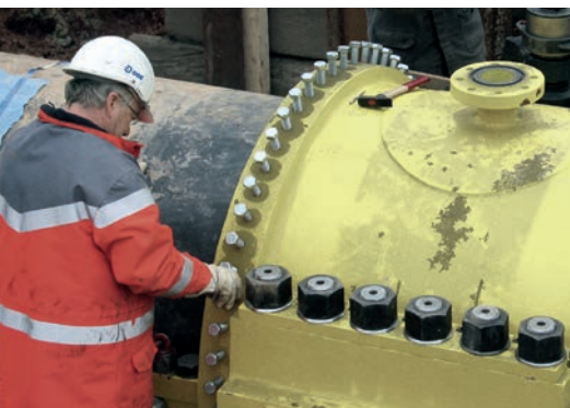
Leitungssicherung mit Reparaturüberwurf
