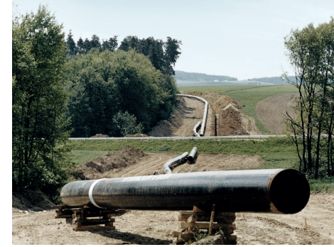
Während einer Leitungsbaumaßnahme
